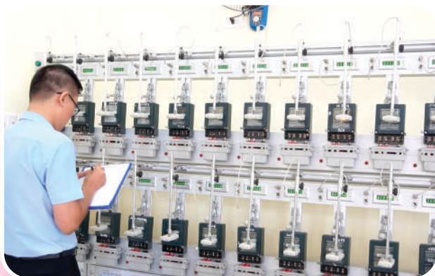
Kiểm định công tơ điện.
