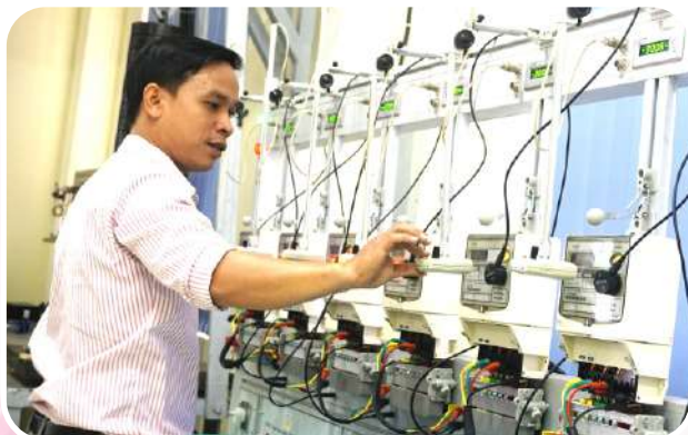
Kiểm định công tơ điện.
