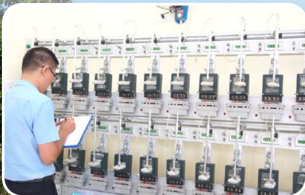
Kiểm định công tơ điện.
