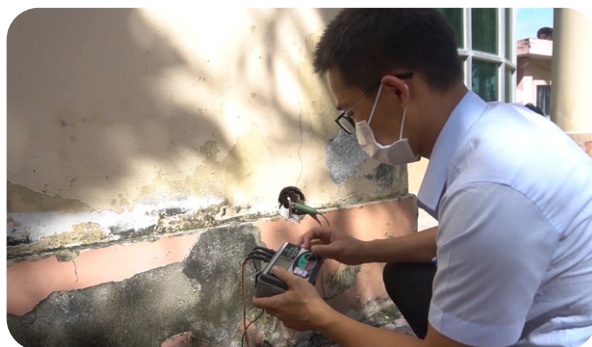
Đo thử nghiệm tiếp địa chống sét.
