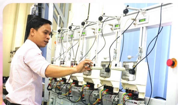
Kiểm định công tơ điện.
