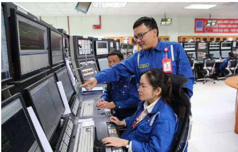
Các kỹ sư vận hành tại Nhà máy Lọc dầu Dung Quất.
