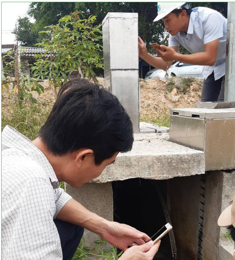
Sử dụng thiết bị di động để điều khiển cửa Van.
