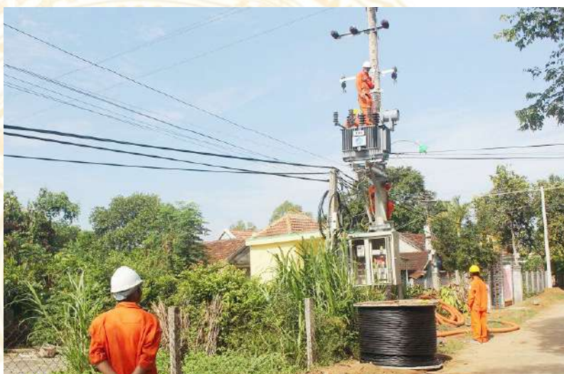
Công ty Điện lực Quảng Ngãi đầu tư xây dựng các công trình điện trên địa bàn tỉnh.
