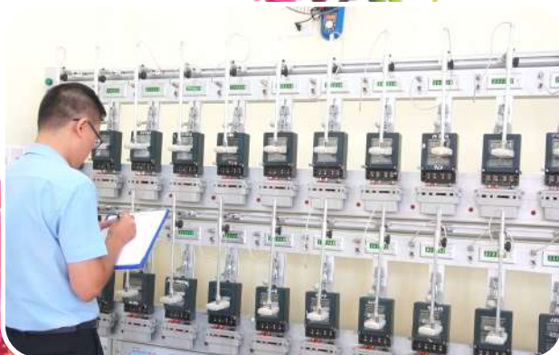
Kiểm định công tơ điện.
