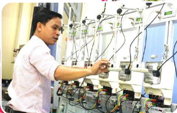
Kiểm định công tơ điện.
