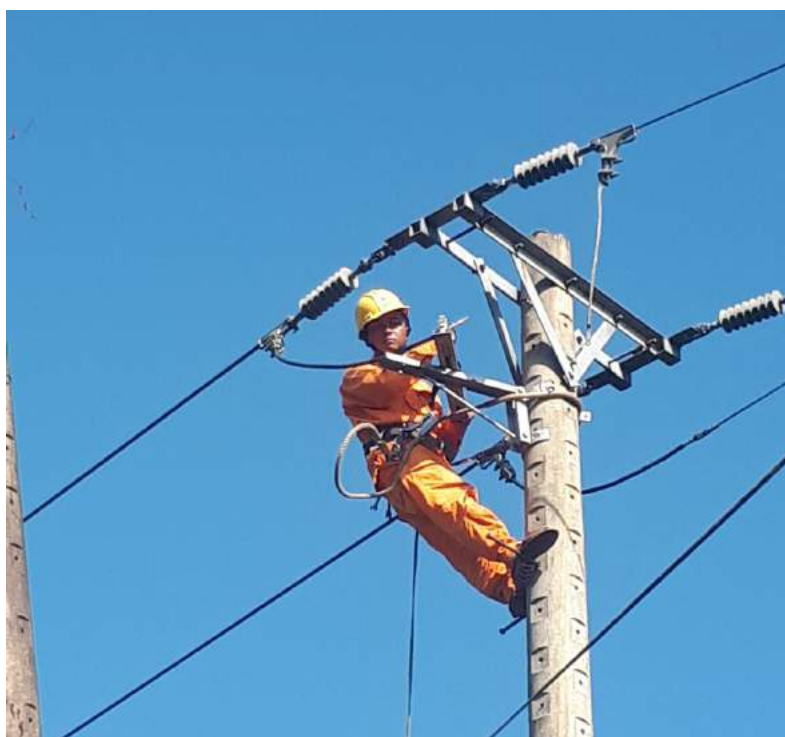
Giải pháp “Bộ giá đỡ kim thủy lực trên không” Trần Quang Thắng đã được áp dụng vào quá trình thi công lưới điện của Công ty Điện lực Quảng Ngãi.
