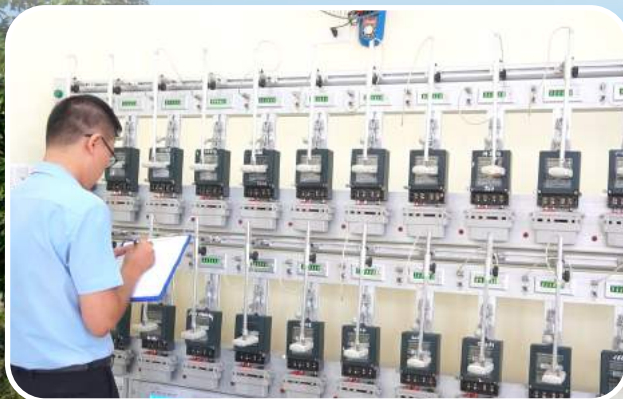
Kiểm định công tơ điện.
