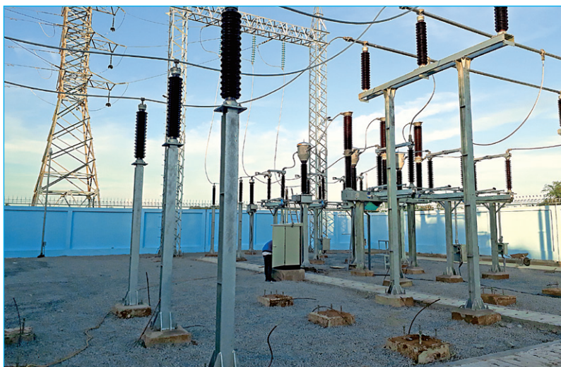
Công ty An Ngãi thi công công trình Trạm biến áp 110kV.
