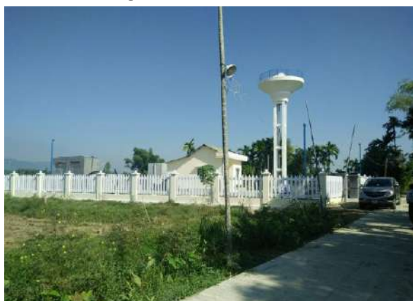
Hệ thống cấp nước sạch xã Phổ Thuận, thị xã Đức Phổ.
