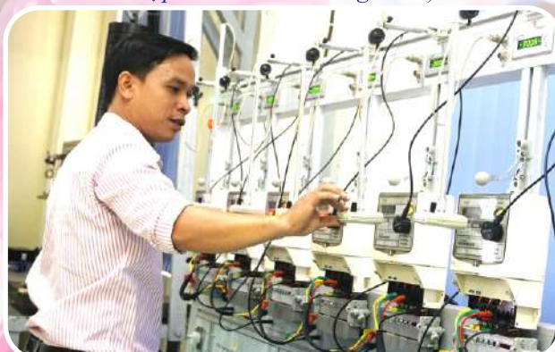
Kiểm định công tơ điện.
