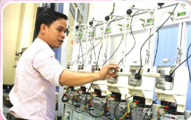
Kiểm định công tơ điện.
