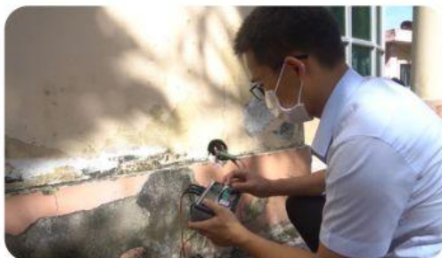
Đo thử nghiệm tiếp địa chống sét.
