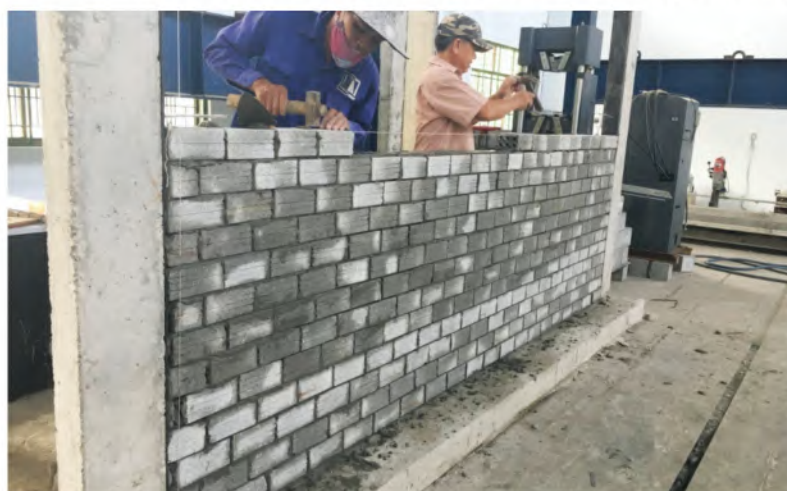
Tường xây bằng gạch xi măng cốt liệu.
