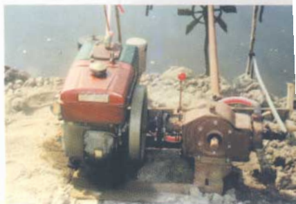
Hệ thống máy nổ + motuer đập nước
