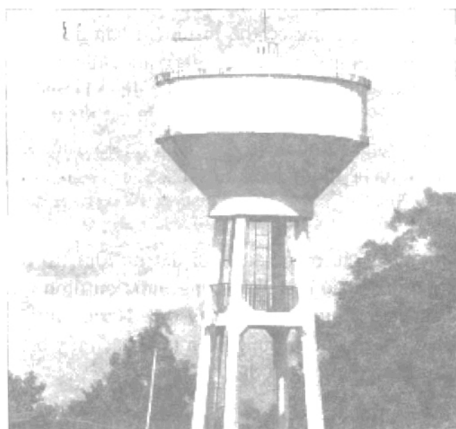
Hình 4 Bể chứa nước xây cao
