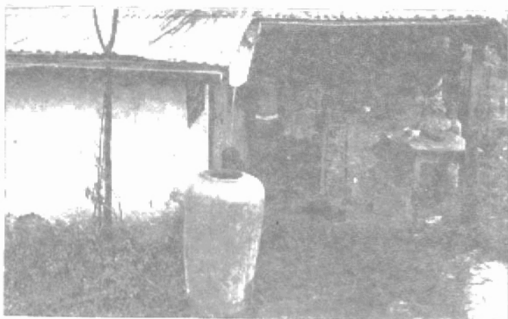
Hình 11 Hứng nước mưa để sử dụng
