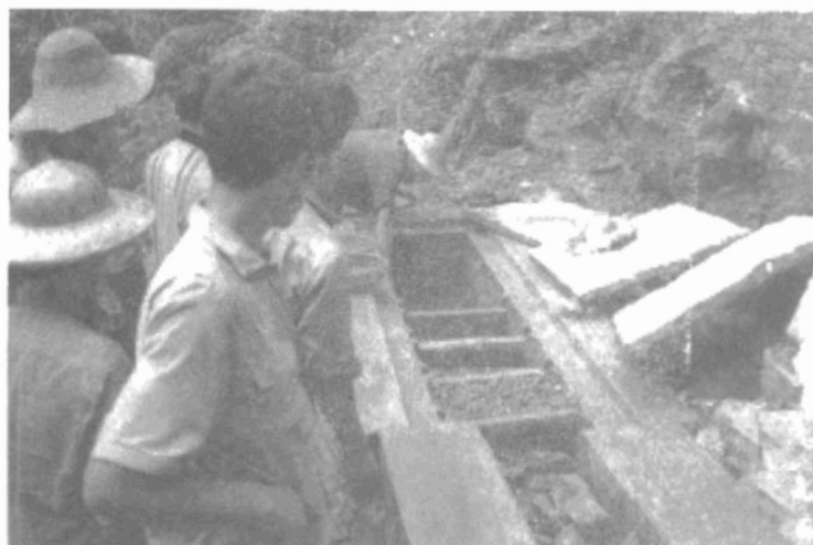
Hình 10. Xây hệ lọc của hệ thống dẫn nước từ khe suối miền núi
