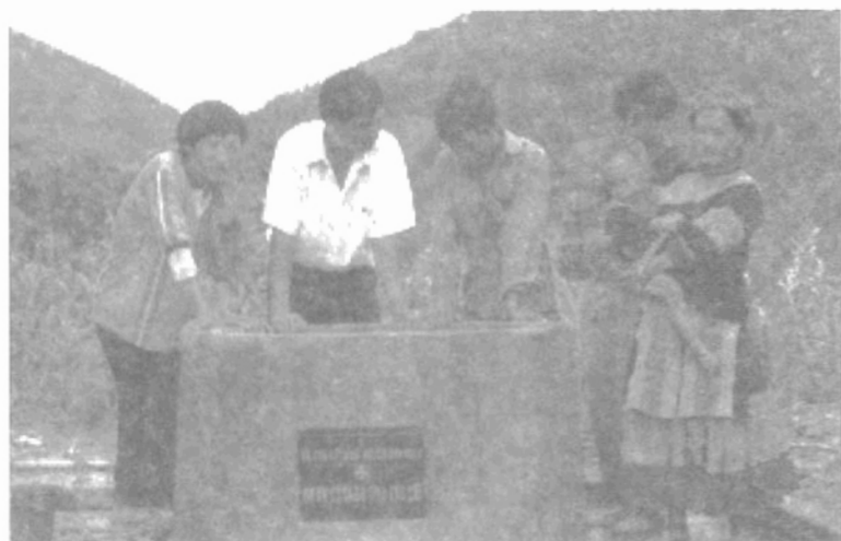
Hình 5. Giếng đào có xây thành bảo vệ
