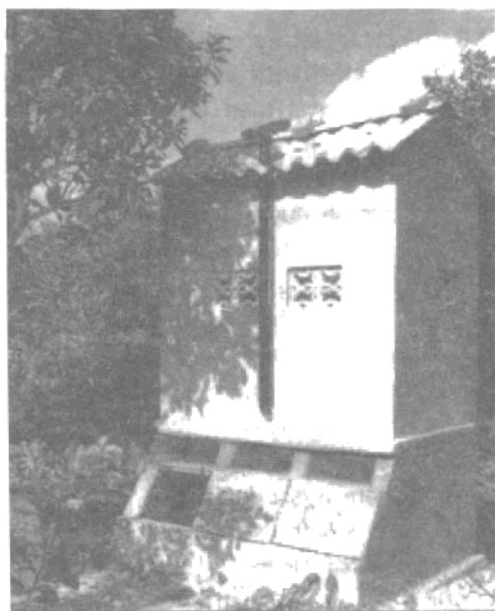
Hình 17. Nhà tiêu 2 ngăn thông hơi cải tiến
