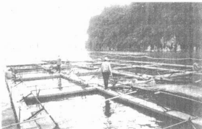
Hình 2. Lồng Composite cỡ 3 \times 3 \times 3 m đang nuôi ở Quảng Ninh.
