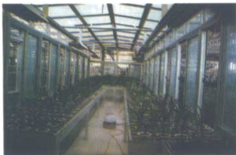
Nhà kính trồng lan kết cấu bằng kính và khung nhôm hợp kim khép kín hoàn toàn.
