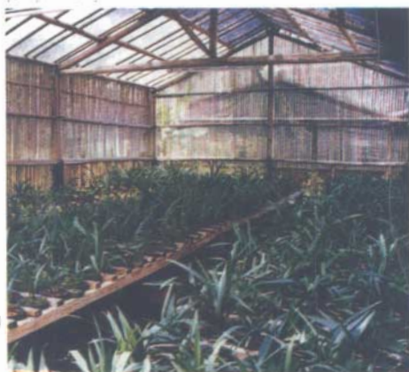
Nhà trồng lan kết cấu bằng gỗ đơn giản. Nhà trồng lan kết cấu bằng gỗ đơn giản
