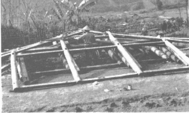
Chuẩn bị dựng nhà. Ảnh: Tấn Vĩnh
