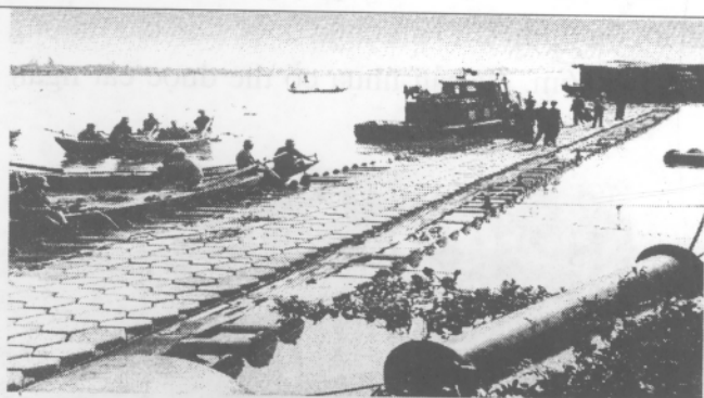
Thi công lắp ghép lưới thảm P.Đ.TAC-M
